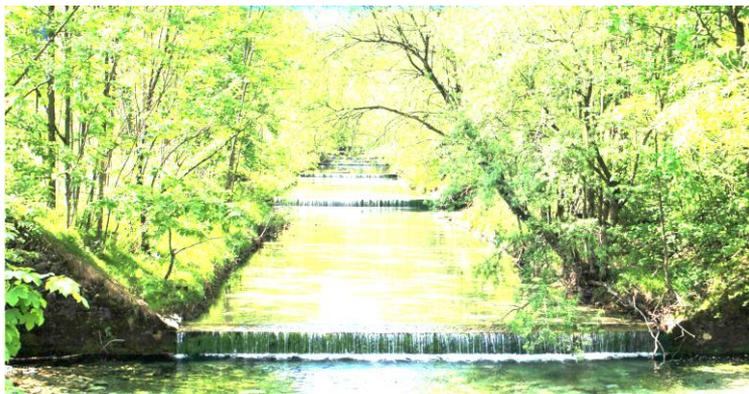
Si sono quindi intrapresi studi di modellazione numerica a fondo mobile sulle variazioni morfologiche indotte da opere di sistemazione trasversali a basso impatto ambientale e interventi di regimazione e correzione d'alveo finalizzati alla mitigazione della *stream power*. Ciò in coerenza con le leggi del modellamento dei corsi d'acqua e i processi di trasporto solido
